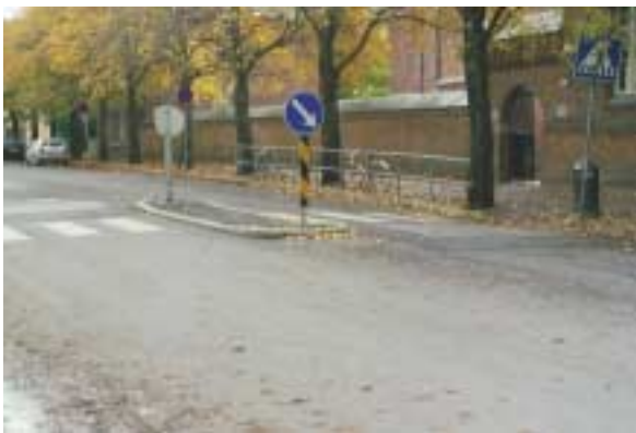
Opphøyd gangfelt med trafikkøy ved porten til skolen
