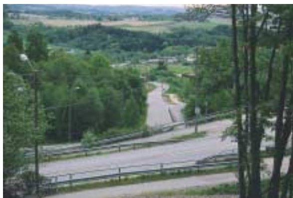
Fotgjengerundergangen ligger i forholdsvis bratt skråning og blir brukt, sjøl om den ikke er særlig tiltalende!
