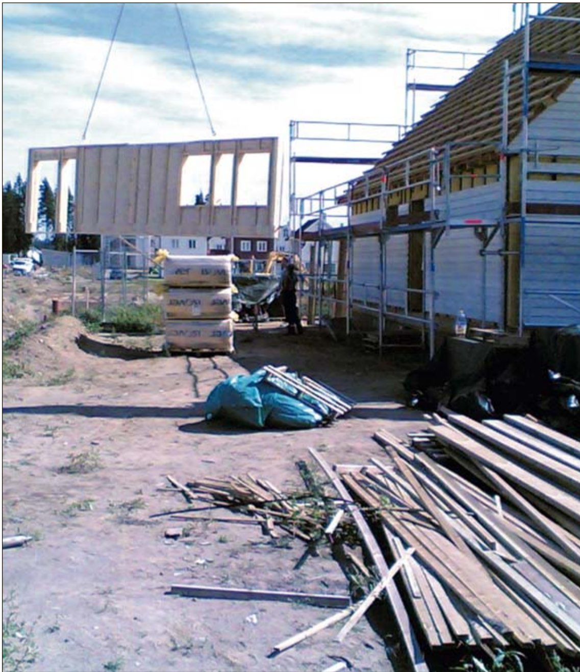
HEIST PÅ Plass: En rekke av husene på Nordbyhagen er modulbygg fra Øst-Europa. Her blir en vegg heist på plass sommeren 2006. FOTO: NINA SKYRUD
